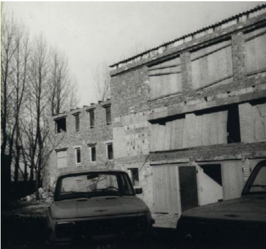
Bild 11: Bildungshaus Zwochau im Bau
