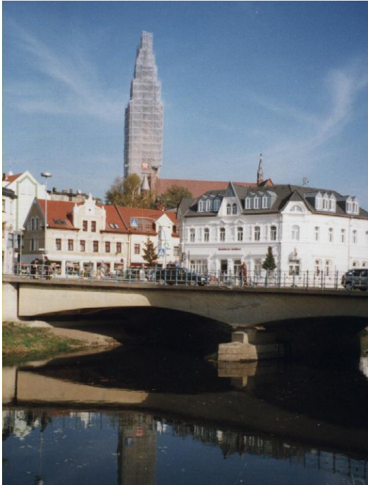
Bild 20: Der eingerüstete Kirchturm
